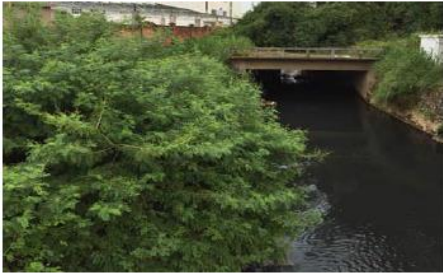
图 5.5-5 调研实景（龙沥大排坑）
