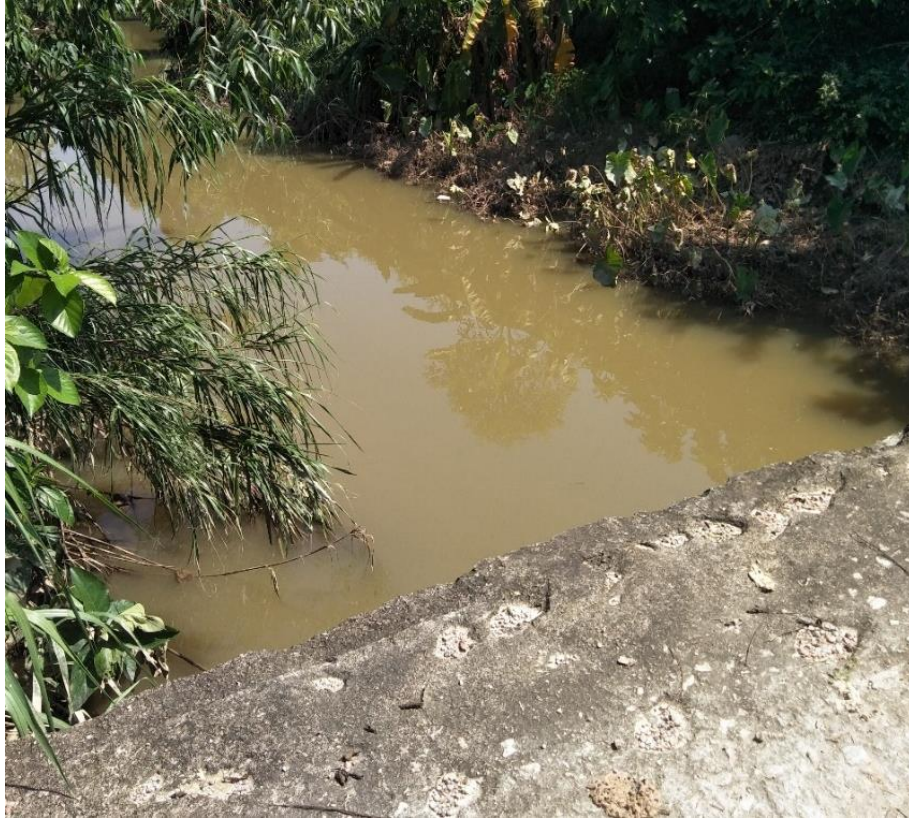
图 5.5-10 调研实景（神石电排坑新村水库支流）
